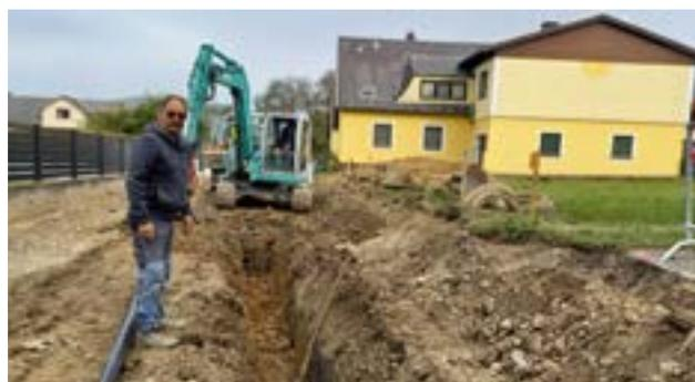
In der Zaunergasse wurden umfassende Bauarbeiten durchgeführt. Die Generalsanierung beinhaltet den kompletten Unterbau und eine neue Asphaltdecke, des weiteren auch den Austausch der Wasserversorgungsleitungen sowie die Verle-
