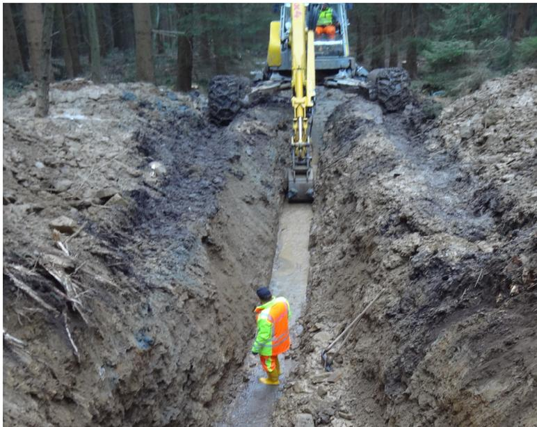
Vor kurzem wurden mit einem Spezialbagger der Firma Schönhofer Grabarbeiten im oberen Bereich der Pfarrgrundstücke für die Erschließung von neuen Quellen durchgeführt.
