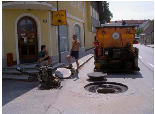
Auf der B 36 im Bereich der Hauptstraße und Altenmarktstraße wurden die schadhafte Kanaldeckel ausgetauscht und durch neue, dem modernen technischen Stand entsprechende, ersetzt.
