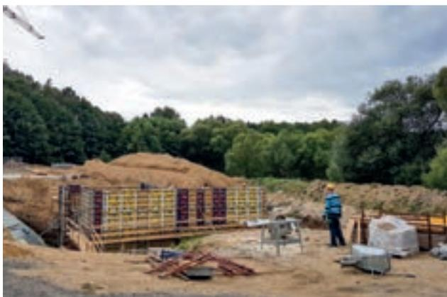
Bei hohen Niederschlagsmengen kann die Kläranlage die anfallenden Mengen nicht fassen, dieses Überlaufbecken dient daher in Zukunft als Zwischenspeicher. Nach dem Niederschlagsereignis wird das gespeicherte Abwasser zu dessen Reinigung langsam der Kläranlage zugeführt.
