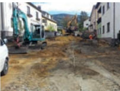
tenmarkt statt. Dabei wurde grundsätzlich ein Konsens zur Durchführung gefunden. Der Gemeinderat stimmte für die Erneuerung aller Wasser- und Kanalleitungen sowie die Neuerrichtung der desolaten Steinmauern. Bei Fertigstellung des Projektes wird der obere Marktplatz in neuem Glanz erstrahlen. Mit dem Projekt „Marktplatz der Zünfte“ wird auch noch ein Stück Geschichte dieses Platzes festgehalten.
