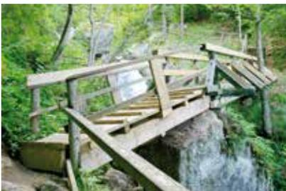
Das Naturdenkmal Ysperklamm wurde durch die Organisation von Vzbgm. Veronika Schroll einer intensiven Sanierung unterzogen. Die Firmen Hagenleithner und Pöchlinger - beide Firmen aus dem Yspertal - tauschten die Tragkonstruktion aus, es wurden neue Unterlager angebracht, Geländer und Holzkonstruktionen erneuert, diverse Böden saniert und verstärkt sowie Verstrebungen angebracht.
